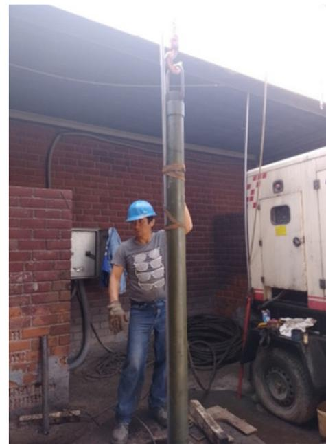
Pozo Chocope N°01, cambio total de tubería de descarga.
