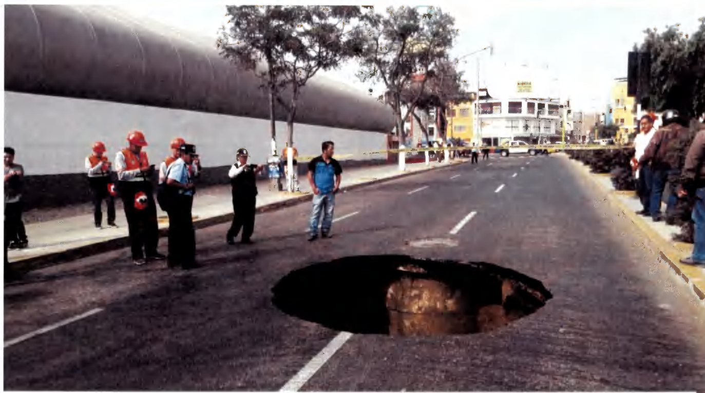
HUNDIMIENTOS DEL PAVIMENTO Y COLAPSO DE TUBERIAS EN TRUJILLO A CONSECUENCIA DEL FEN COSTERO (2017)
