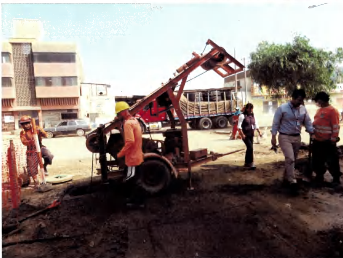
LIMPIEZA DE TUBERIAS DE ALCANTARILLADO CON APOYO DE MAQUINARIA (HIDROJET Y MAQUINA DE BALDE) POR OBSTRUCCIONES EN SUS TRAMOS DEBIDO AL FEN COSTERO
