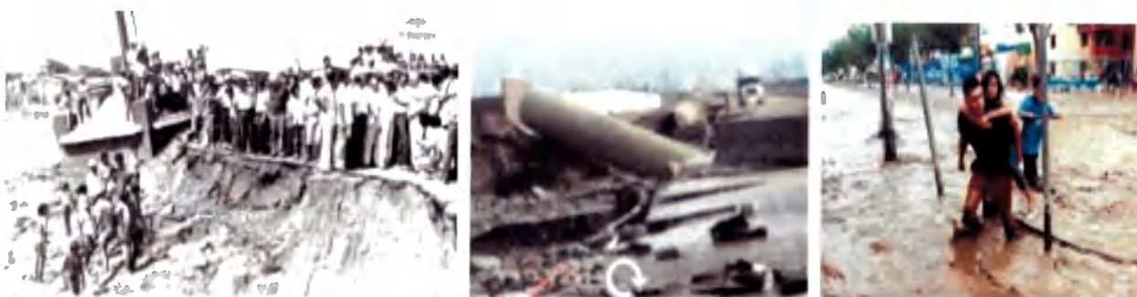
Años 1983 y 1997 daños causados en La Libertad a consecuencia de fenómeno El Niño y FEN Costero
