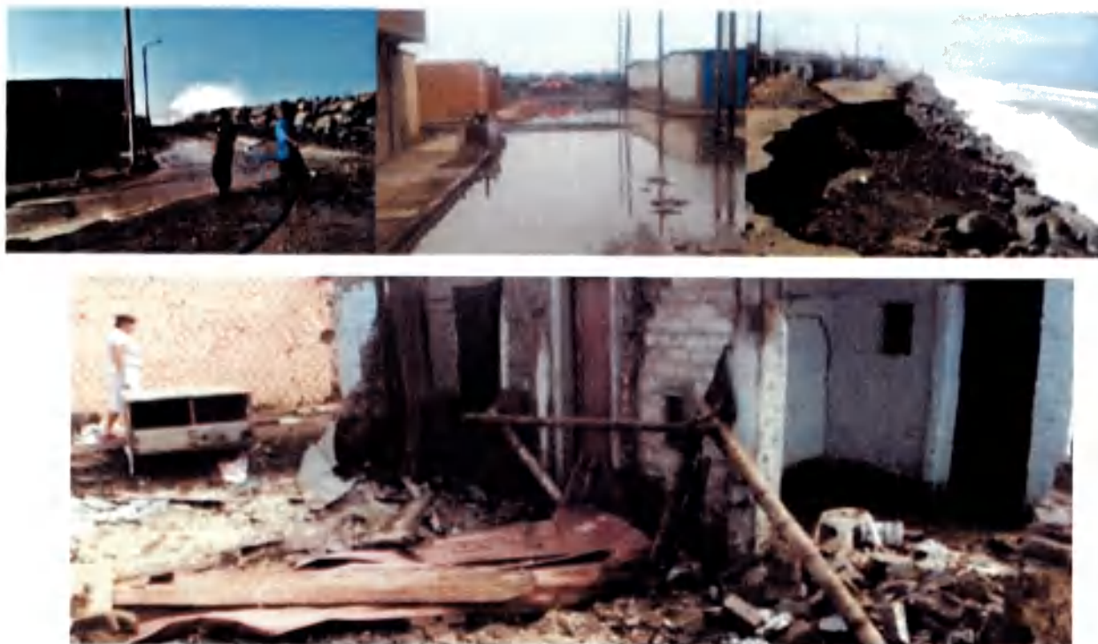
VIVIENDAS INUNDADAS Y CALLES ANEGADAS EN EL ASENTAMIENTO HUMANO LOS DESAMPARADOS DEL DISTRITO DE VÍCTOR LARCO, PRODUCTO DE LOS OLEAJES ANÓMALOS QUE SE PRESENTAN EN LOS BALNEARIOS DE LA PROVINCIA DE TRUJILLO.
